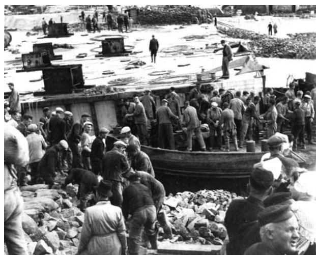
Afsluiting van het dijkgat te Westkapelle; met man en macht wordt een caisson in positie gebracht, oktober 1945. Foto: Neeltje Flipse-Roelse, nr 037 PH
