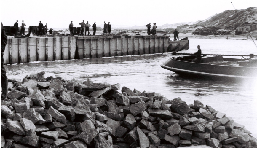
Een intermediate-ponton wordt ingevaren in het sluitgat bij Westkapelle. Verzameling N. Flipse-Roelse, nr 610 NFR
