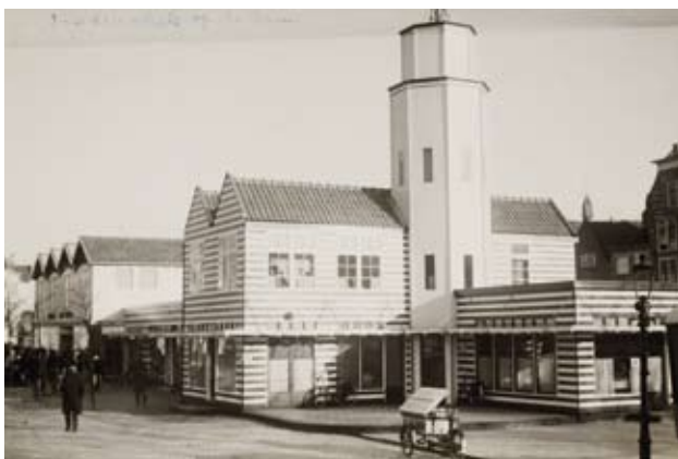
De tijdelijke stad. Noodwinkels aan de Dam te Middelburg, 1940-1941, HTAM-P-1523.
